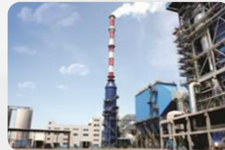
Сероочистка дымовых газов аммиачным способом
